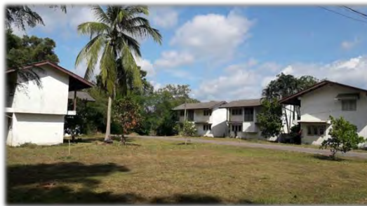
สถานีวิทยุ บริเวณคาดฟ้าอาคารอำนวยการ
